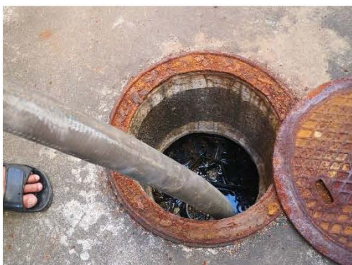
ภาพที่ 2.2-11 การสูบลบตะกอนระบบบำบัดน้ำเสีย
